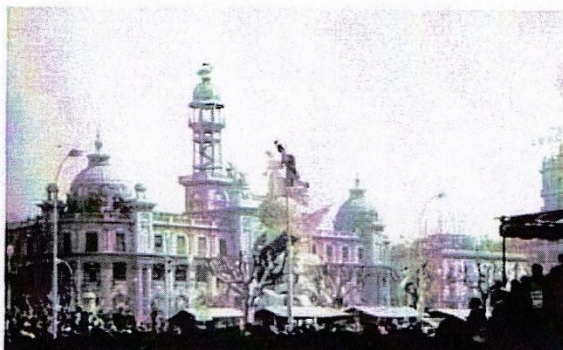
(F-2) Falla frente a Correos
