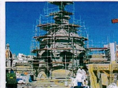
(F-189) Cúpula en fase de limpieza
