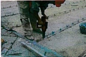
(F-103) Montaje de los conectores
