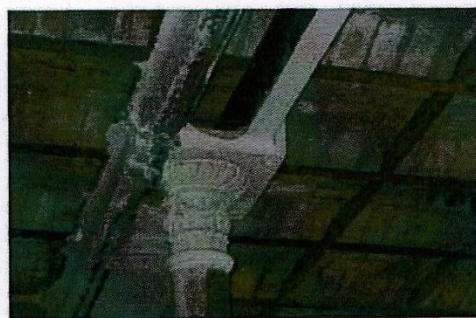
(F-101) Viga en doble pieza
