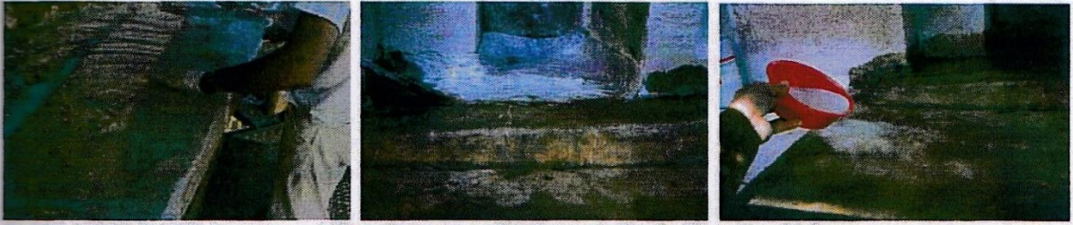
(F-167,F-168,F-169) Impermeabilización con poliéster y malla de fibra de vidrio
