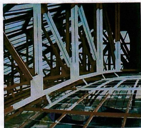
(F-97) Tratamiento de la estructura
