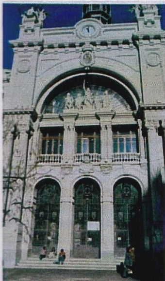
(F-236) Acceso principal
