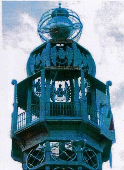
(F-190) Cubierta acabada
