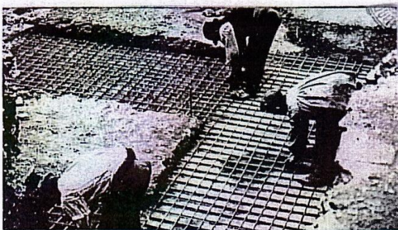
(F-27) Zapata en ángulo para muro
