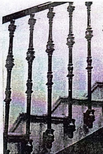
(F-83) Barandilla escalera
