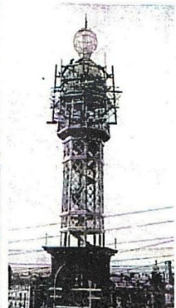
(F-57) Montaje cúpula
