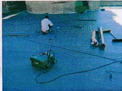
(F-185) Montaje lamina impermeable
