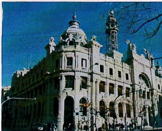
(F-228) Vista general del edificio
