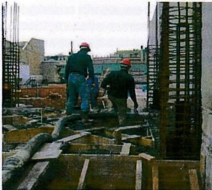
(F-115) Hormigonado cemento torre
