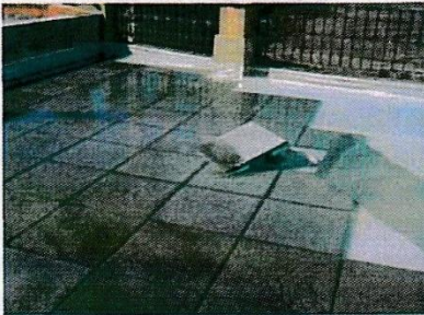
(F-186) Losas filtrantes de hormigón
