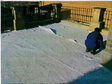
(F-184) Instalación fieltro geotextil
