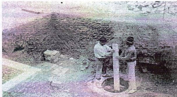
(F-29) Picado cimiento hormigonado
